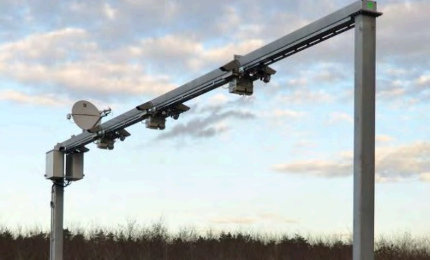
Şekil 2. Otoyolda trafik akışını izleyen sensör ve kamera donanımına sahip gantri düzeneği (U.S. GAO, 2023.)
